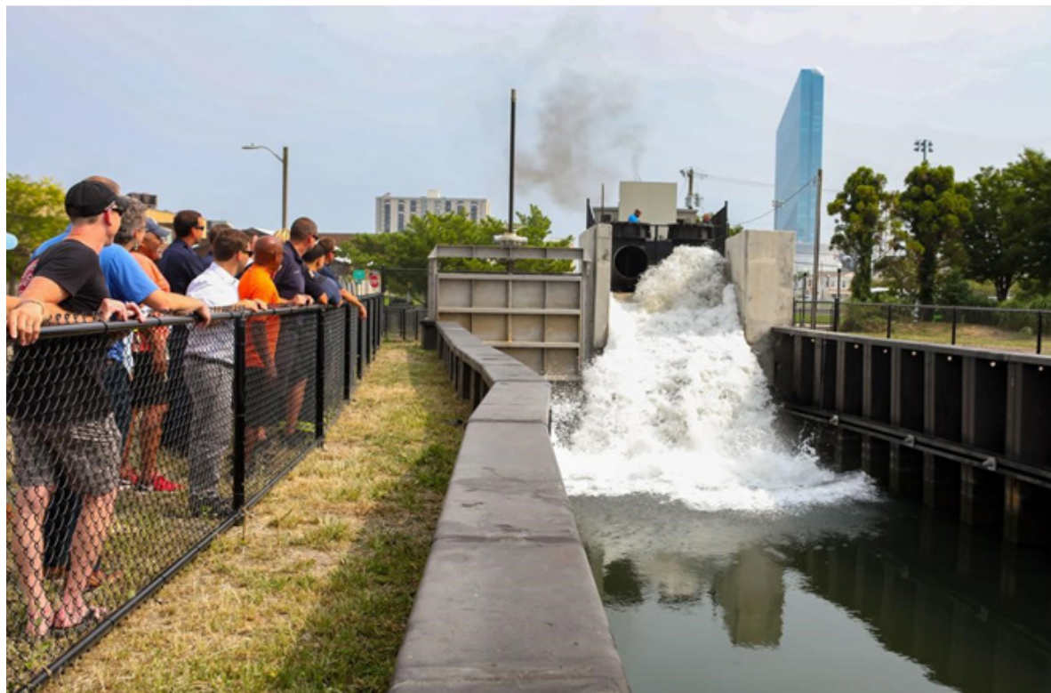
Imagen: Infraestructura subterránea para el control de inundaciones (Canal de Baltic Avenue) en el parque Fisherman's en Atlantic City. El agua escurre de 775 acres de Carreteras al canal para disminuir la inundación. Foto cortesía de: Kristian Gonyea/The Press of Atlantic City
